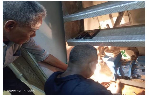
চিত্রঃ বানৌজা বানৌজা তল্লাশী এর ডান এসটিপি পাম্প মেরামতকরণ এর স্থির চিত্র।
