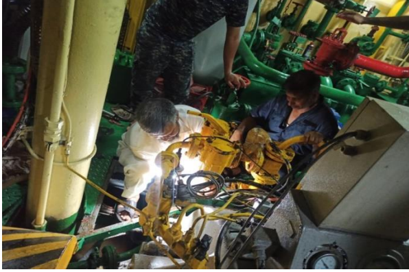
চিত্রঃ বানৌজা বিজয় এর বাম প্রধান ইঞ্জিন এর লুব অয়েল কুলার মেরামতকরণ এর স্থির চিত্র।
