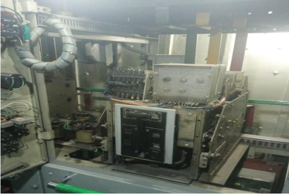
চিত্রঃ বানৌজা আলী হায়দার এর এয়ার সার্কিট ব্রেকার মেরামতকরণ এর স্থির চিত্র।
